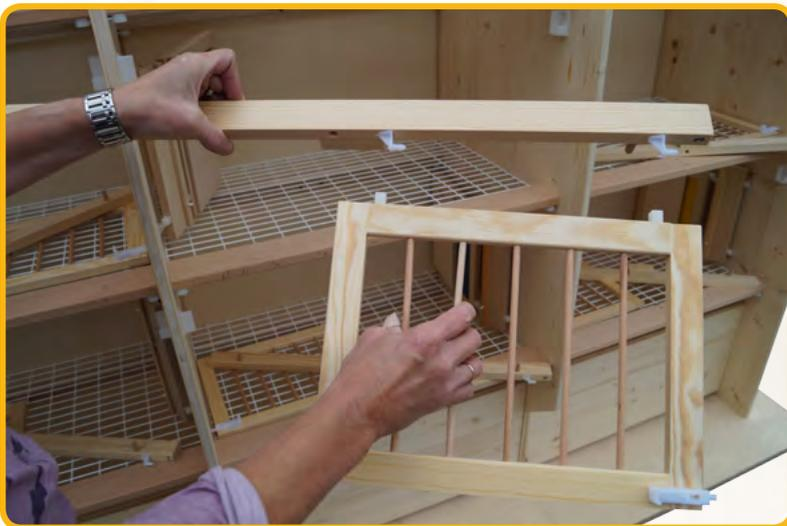
Dann die Vordergitter von außen auf die Haken der Vorderleisten aufstecken. Und beides zusammen in die Halterung einhängen
