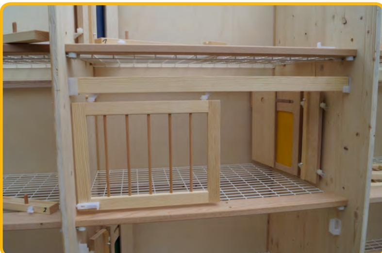
Vorderleisten mit aufgesteckten Vordergittern in allen Zellen einbauen.
